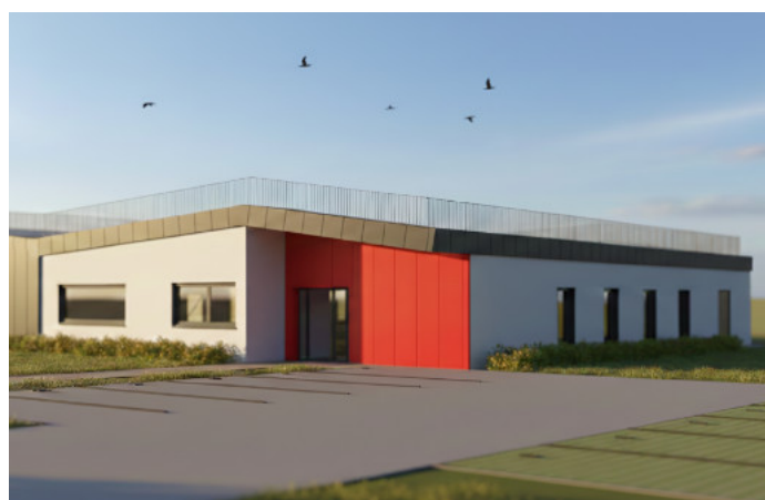
| Ci-dessus : le futur Centre de Secours et d'Incendie
